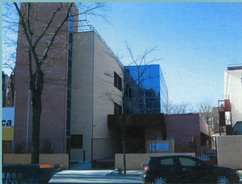
Centro de Salud Casa de Campo
