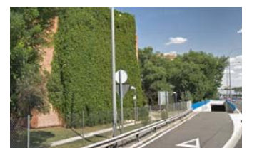
Túnel Casa de Campo
